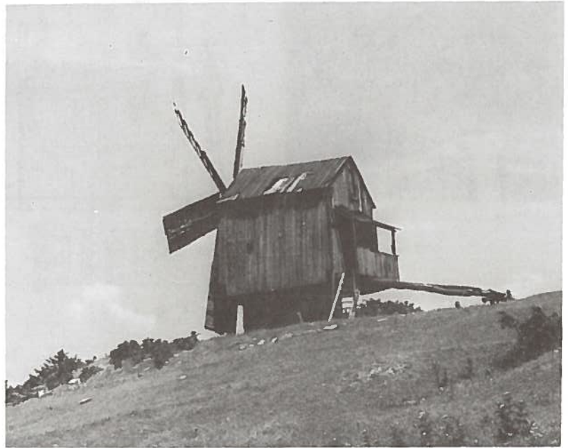
Fig. 34.15 R-50 002- Poșta Mill, Județul Tulcea. UTMn 35/624/5003. The post mill on a stone socle.
